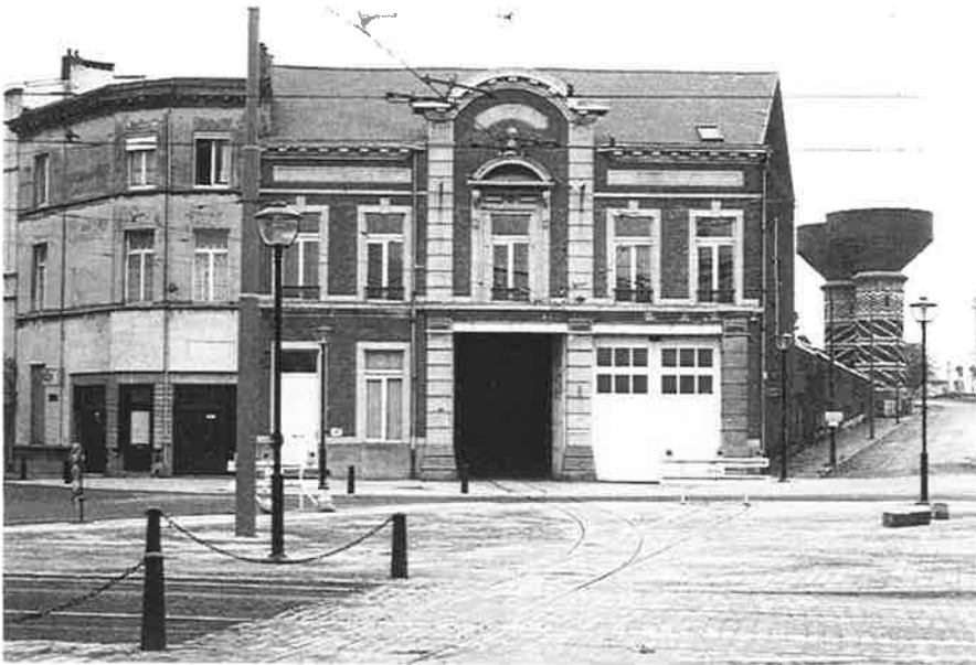
De nieuwe spoor situatie aan de Draakplaats. We kijken op de poorten van de loods Weg en werken. Het spoor rechts op de helling naar het ooststation is niet meer verbonden met het tramnet. De links afbuigende boog is richting stadscentrum. Foto : Luc Couscheir.
